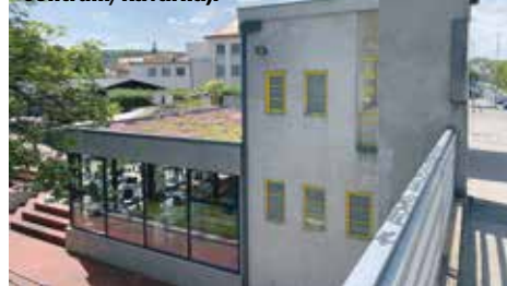
Provozovna v Mostní 22 (turistické informační centrum/kavárna).
