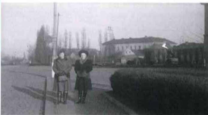
Pohled směrem ke kralupskému mostu před 50 lety.
