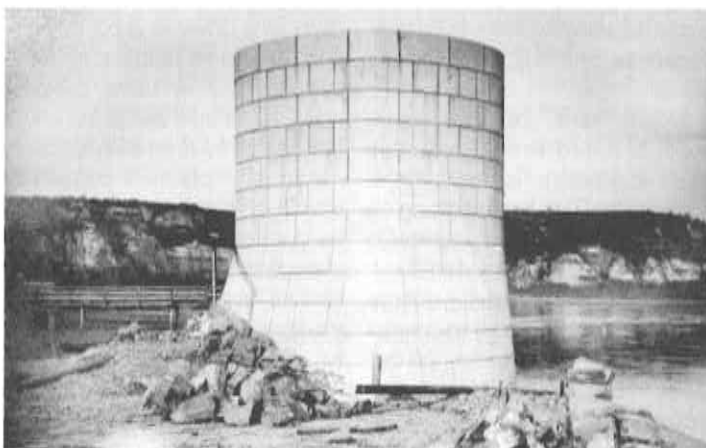
Levý návodní pilíř kralupského mostu po dokončení.
