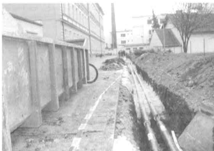
Pohled na v říjnu budovanou část potrubní trasy teplovodu. Budova vlevo je ZŠ Komenského.
