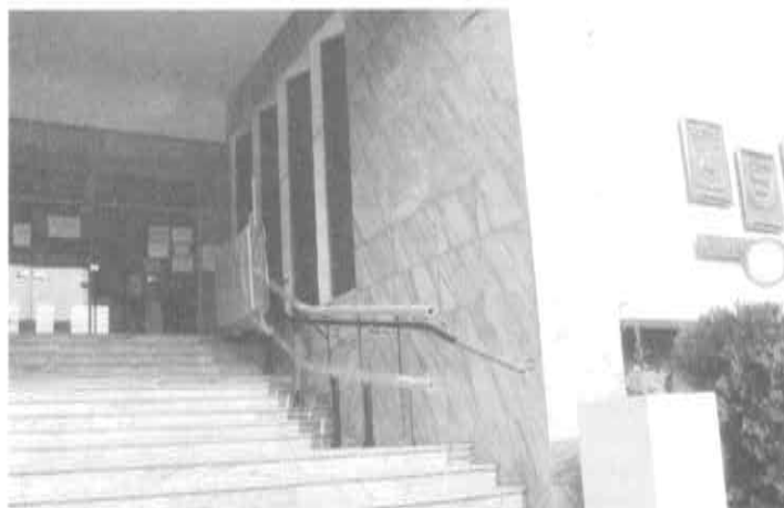
Koncem dubna se před budovou městského úřadu začala instalovat plošina pro imobilní občany.
