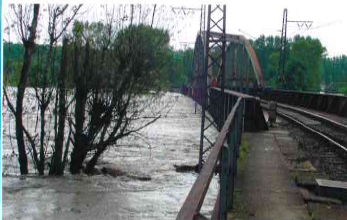
Železniční most u Chvatěrub
