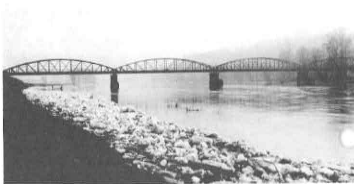
Po tomto železničním mostě přešla pruská vojska v roce 1866 do Kralup. Konstrukce mostu byla tehdy ale odlišná.
