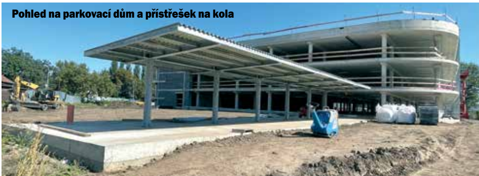
Rekonstrukce Nádražní ulice
