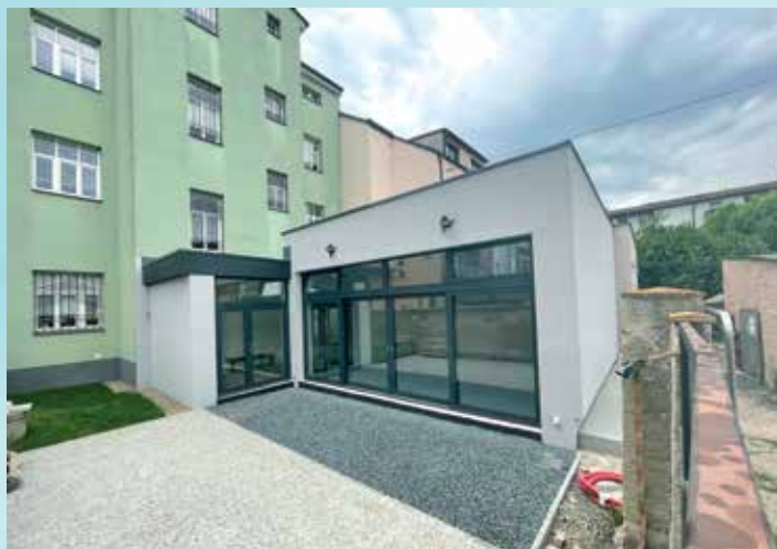
Základní umělecká škola Kralupy se dočkala přístavby multifunkční třídy. Stavba je těsně před jejím dokončením, žáci si tyto nové prostory budou moci vyzkoušet už v letošním školním roce.
