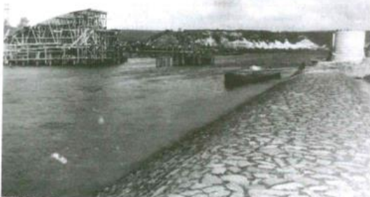
Začátek stavby mostu v roce 1926
