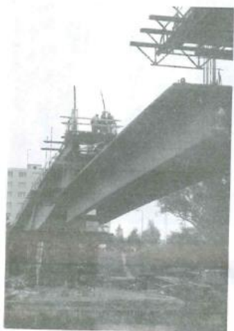
2/ 300 tun betonu v polovině cesty
