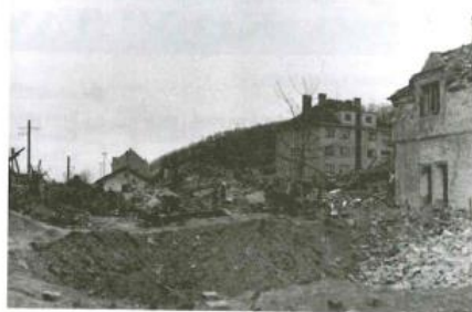
Poděbradova ulice v Podhájji po leteckém bombardování.
