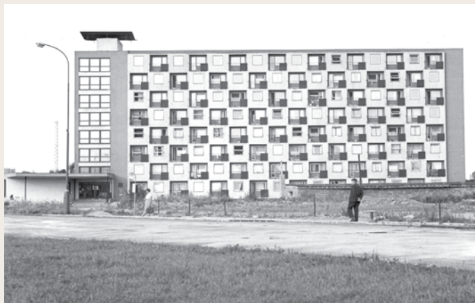
Pro pracovníky Kaučuku byla postavena svobodárna. Pro svůj náter dostala název „šachovnice“.
