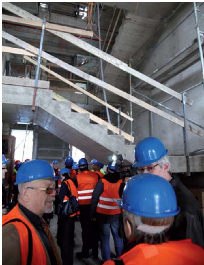
Účastníci exkurze na stavbě budoucího technoparku
