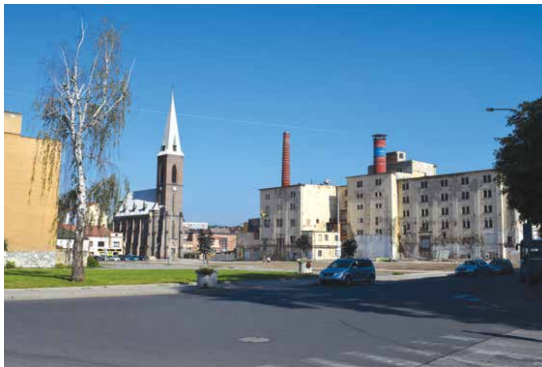
Prostor u kralupského náměstí po demolici budov přiléhajících k pivovaru, který zůstal zachován
