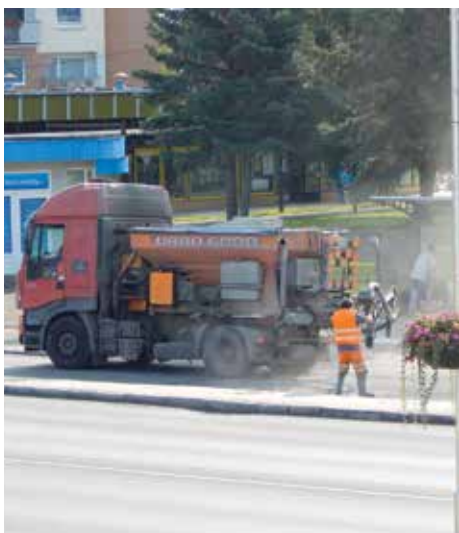
Oprava povrchu parkoviště na Seifertově náměstí tryskovou metodou.
