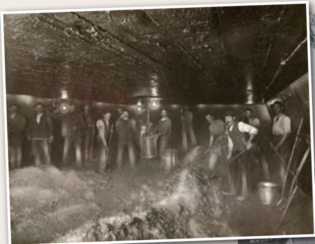
▲ V kesonu. Kopání základů ▲ pro pilíř mostu
