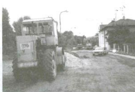
Práce na úpravě nábreží Josefa Holuba začaly.
