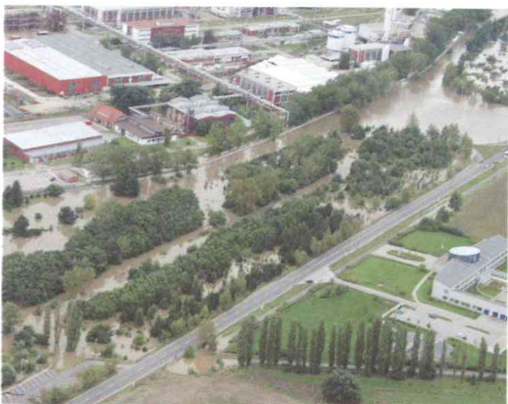
Staronové koryto si řeka našla mezi areálem Kaučuku a budovou Mera.
