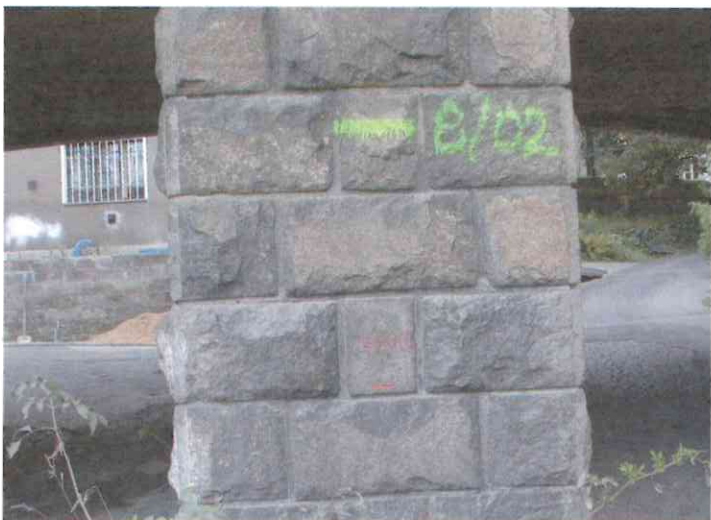
Kamenný pilíř pod železničním přejezdem v Nelahozevsi.
