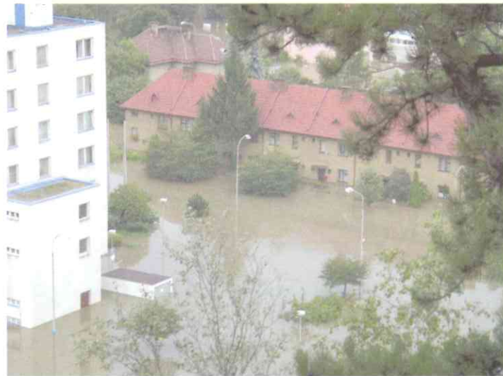
Městský úřad a ulice u Cukrovaru. Výška hladiny dosahovala v těchto místech 3 metrů.
