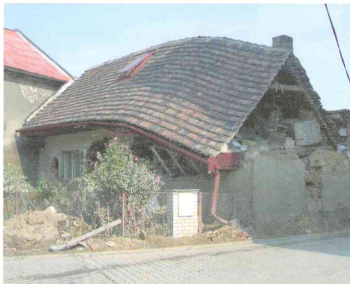
Jeden z domů určených k demolicí Na Hrádku.
