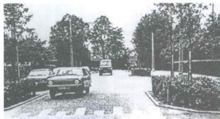
Obr. 3 Zřízení vozovky pomocí bočních poloostrovů se zelení
