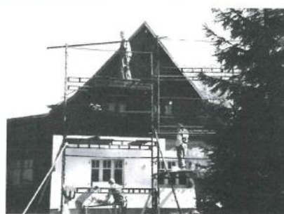
rekonstrukce „Dřevomorky“ foto: V. Hanzl
