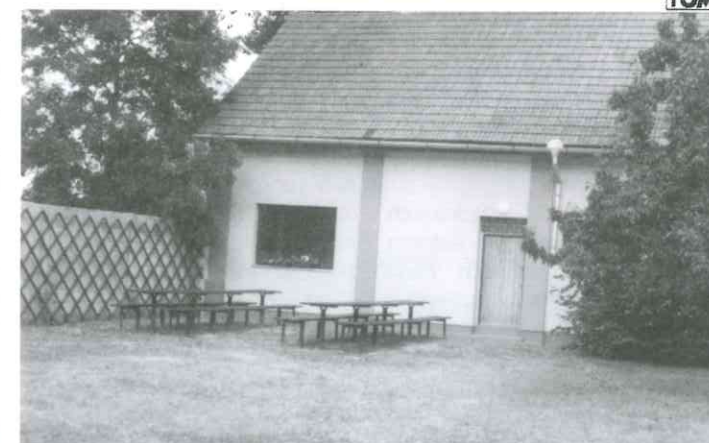
Turistická základna - letní ubytovna
