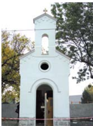
Rekonstrukce kapličky vrcholí – stav k 25. 10. 2012.
