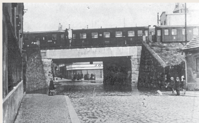
Železobetonový podchod v roce 1940.
