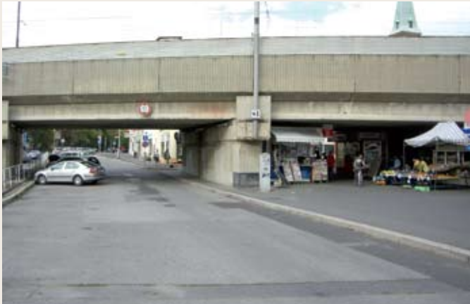
Železniční železobetonový viadukt před stavbou kruhových objezdů.
