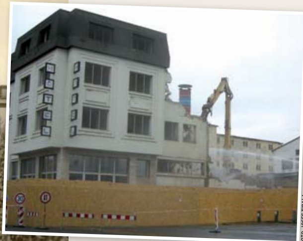
Demolice hotelu Praha v roce 2016
