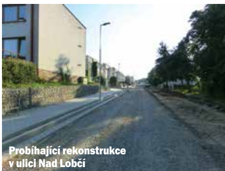
Budoucí parkoviště v Třebízské ulici.
