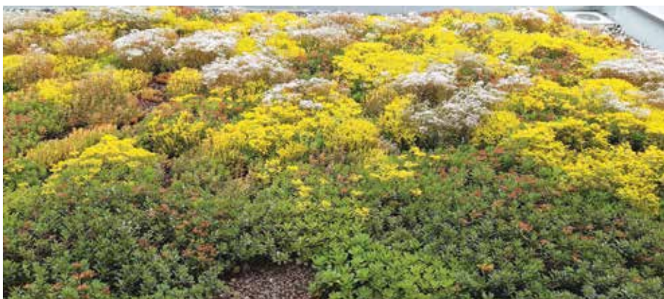
Zelená střecha je jeden ze způsobů zadržování a využívání dešťové vody
