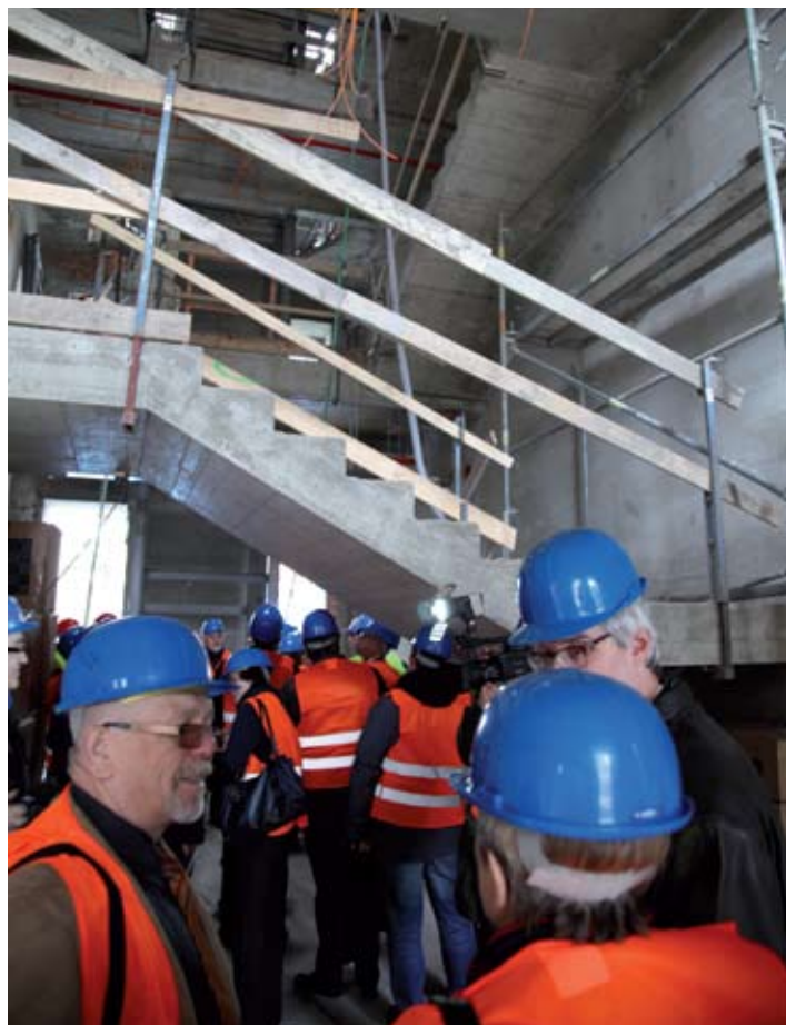
Účastníci exkurze na stavbě budoucího technoparku
