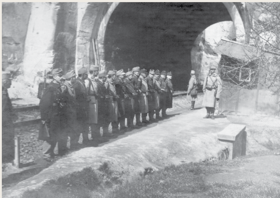
Stráž domobrany před tunelem v roce 1916.
